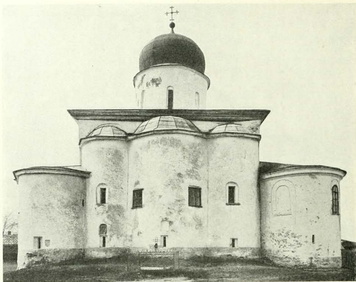
Церковь Ильи Пророка на Славѣ.
