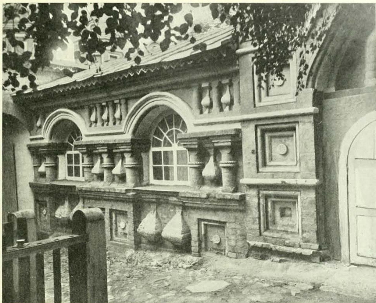
Галерея входа церкви Воскресенія «на Дебрѣ» въ Костромѣ.
